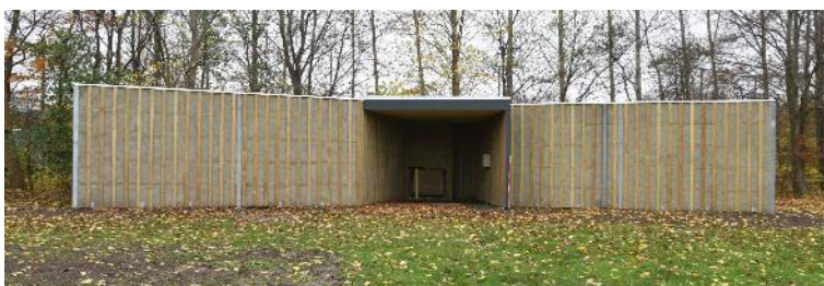
Figur 2. Skydehus og skærme ved J2 / T2
